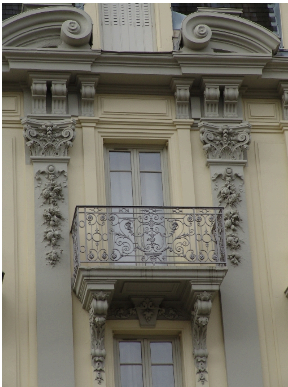
Façade antérieure : décor de la travée centrale
