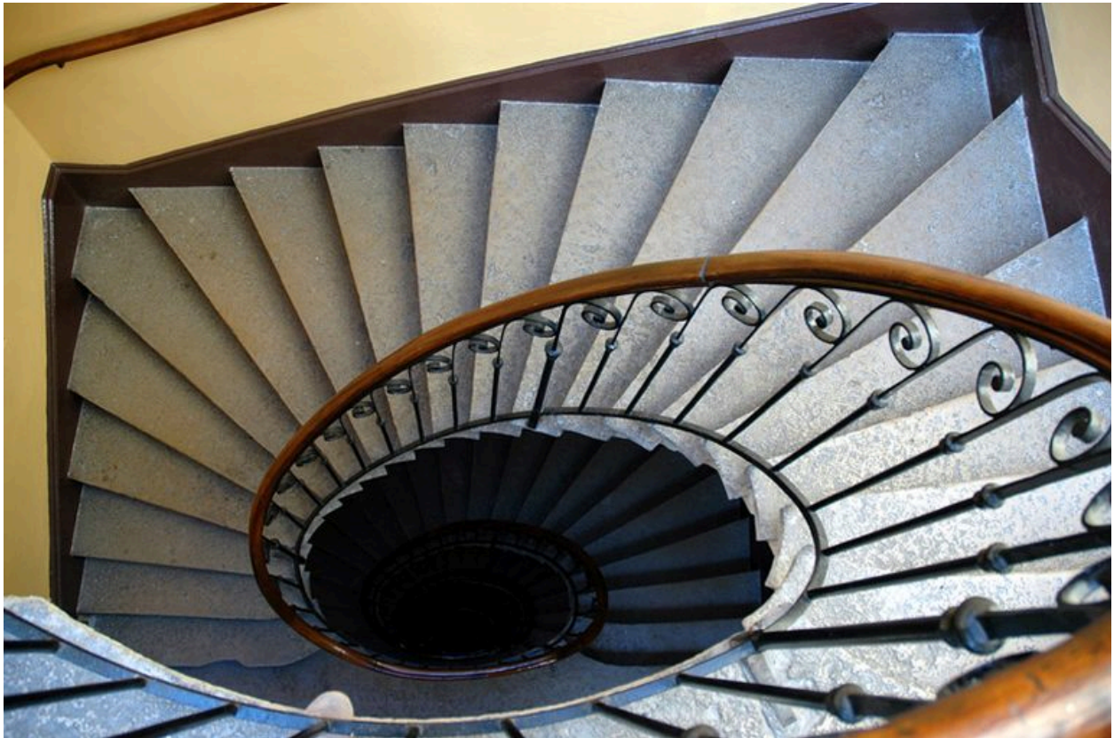
Vue de l'escalier en plongée
