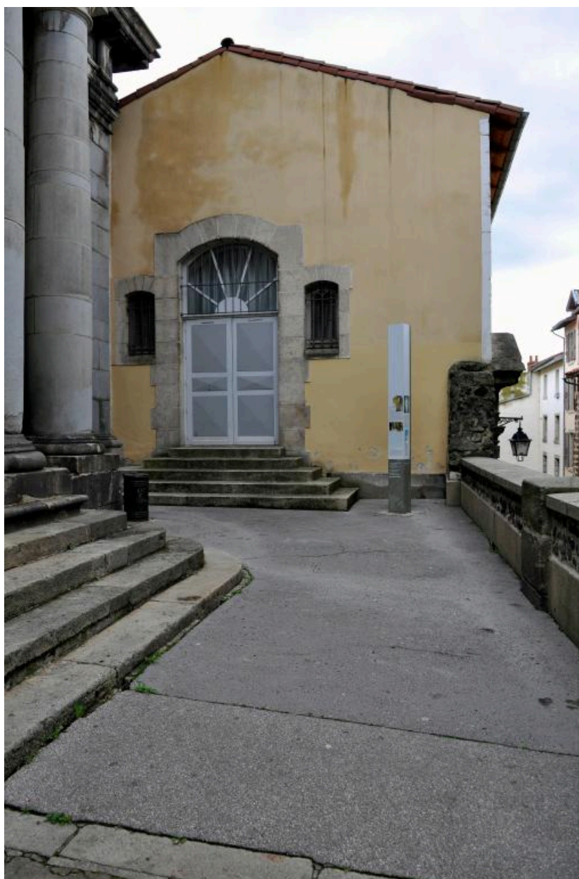
Bâtiment A : ancienne entrée de la bibliothèque municipale au niveau du parvis de l'église, desservant le 1er étage
