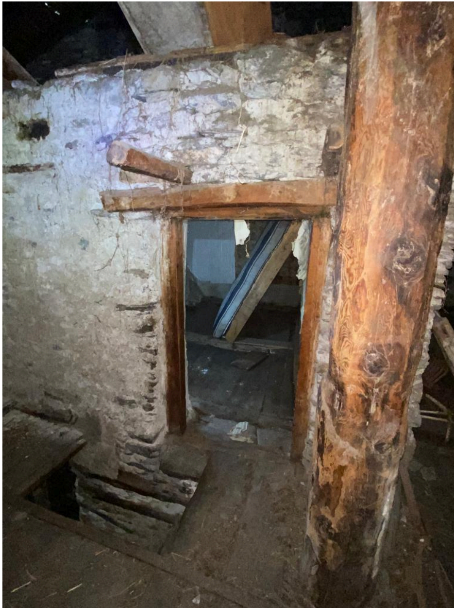
Niveau supérieur, grange, entrée de chambre
