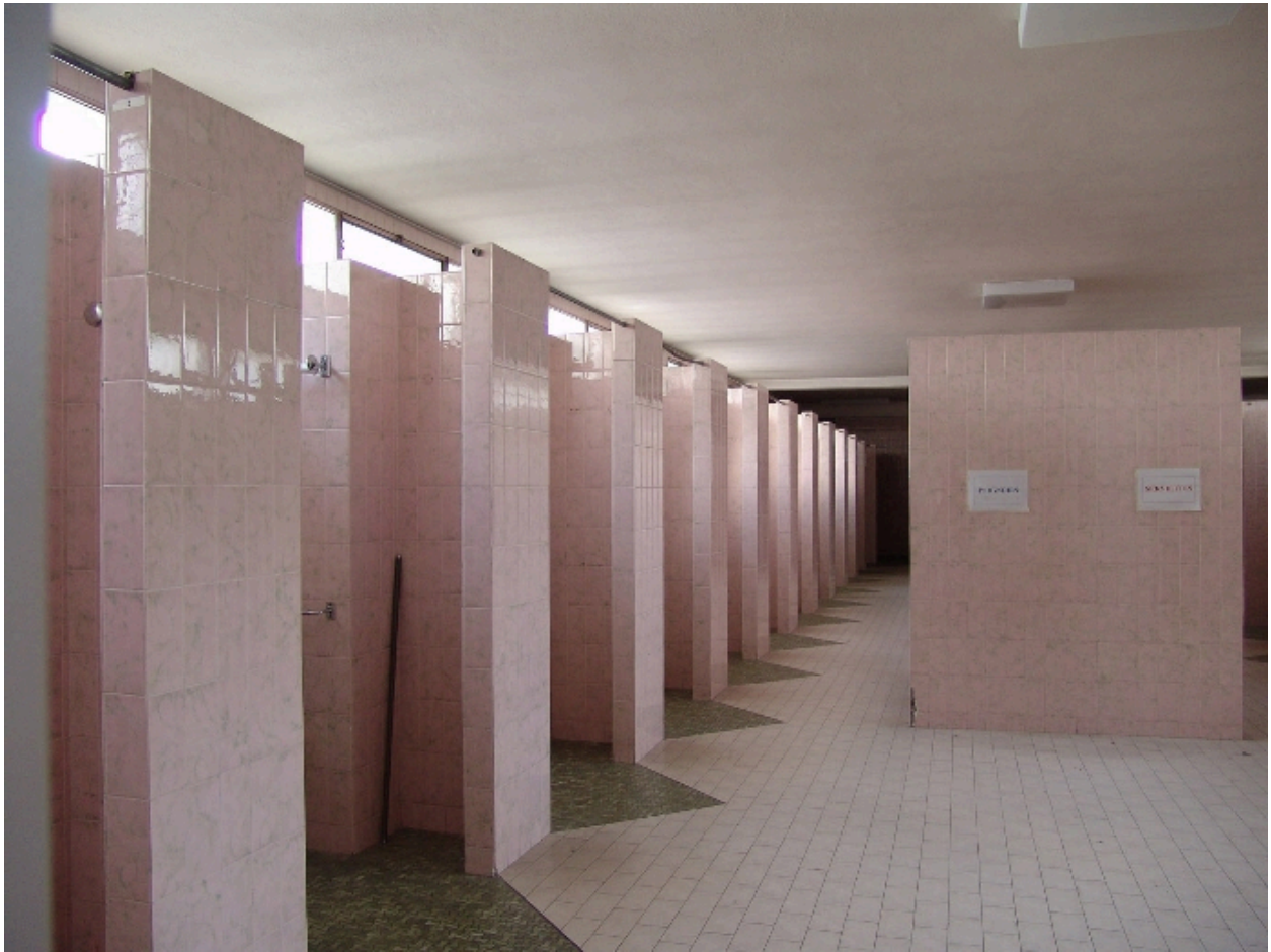
Cabines de pulvérisation au rez-de-chaussée surélevé
