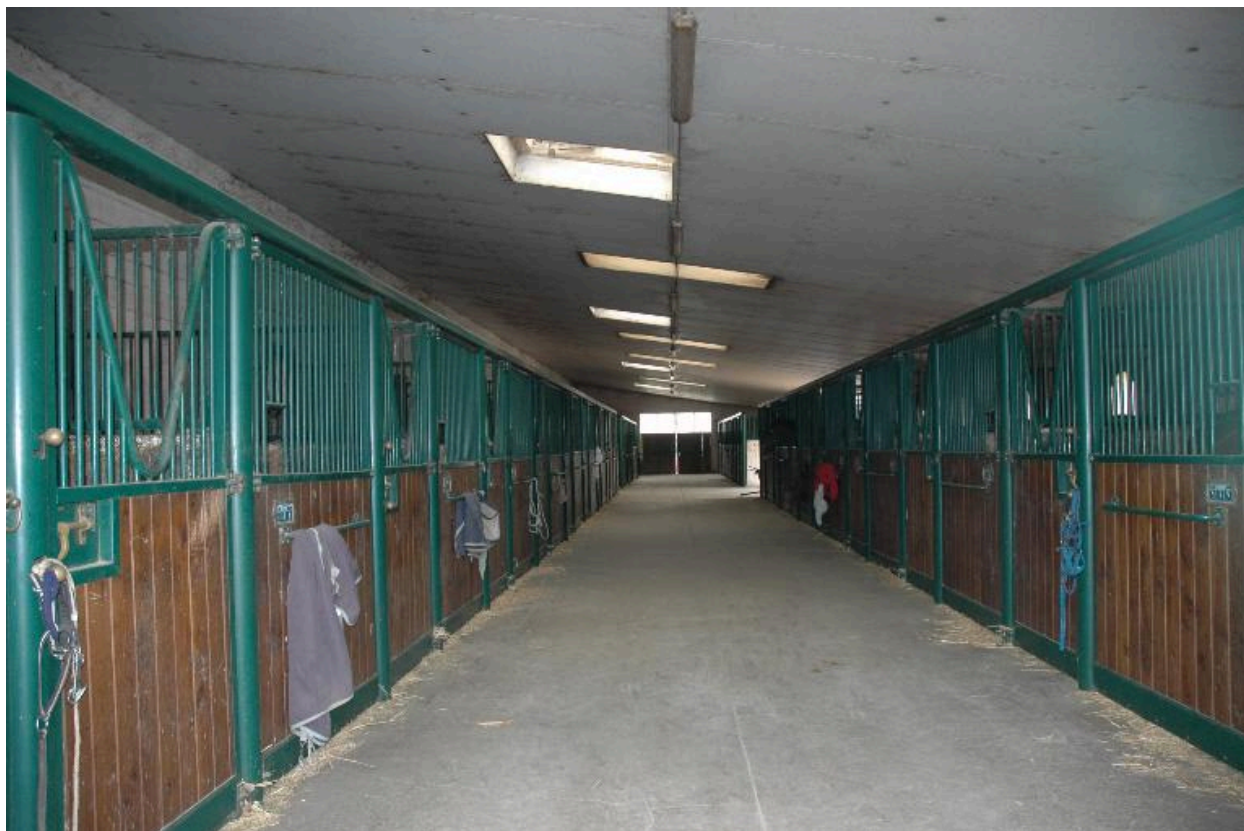
Vue d'ensemble intérieure des box à chevaux du corps de bâtiment ouest de la ferme
