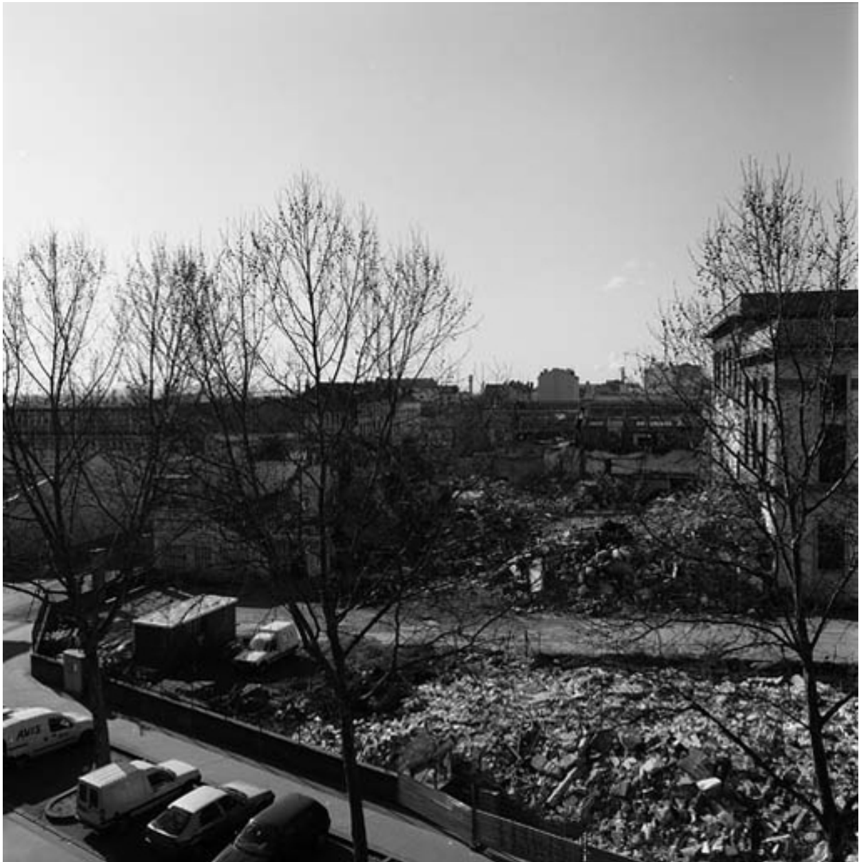
Vue du sud-est, début démolitions
