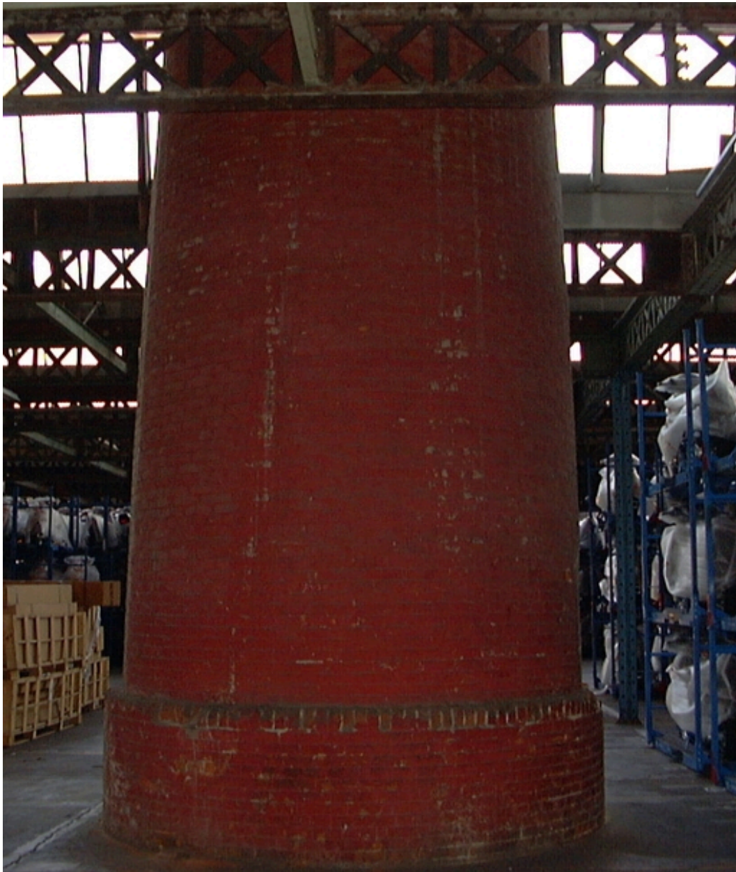
Cheminée en brique coupée
