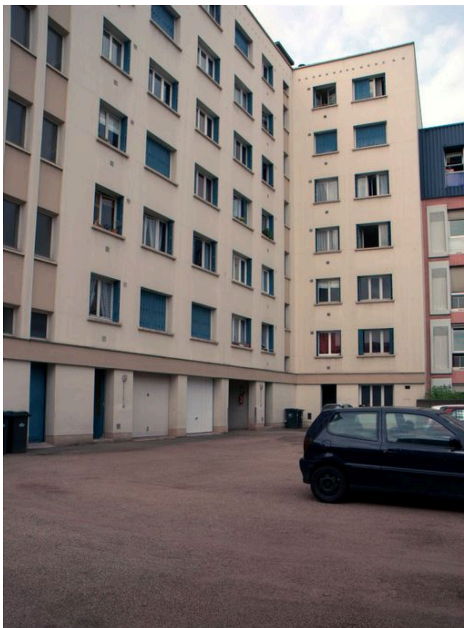
Elévation postérieure, depuis le nord-est
