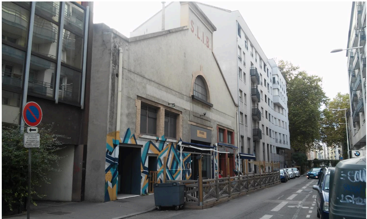
Vue ouest du site usine SLIB
