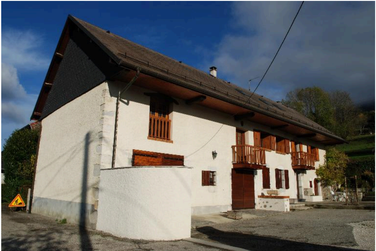
Exertier (les), ferme 2014 B3 884. Vue d'ensemble de la façade principale.
