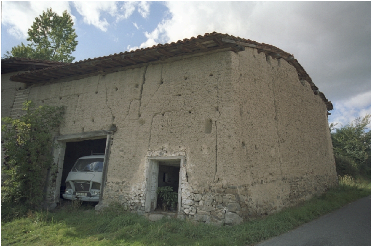
Cezay, Marcy (1987 B2 541), type A1. Vue d'ensemble des communs.
