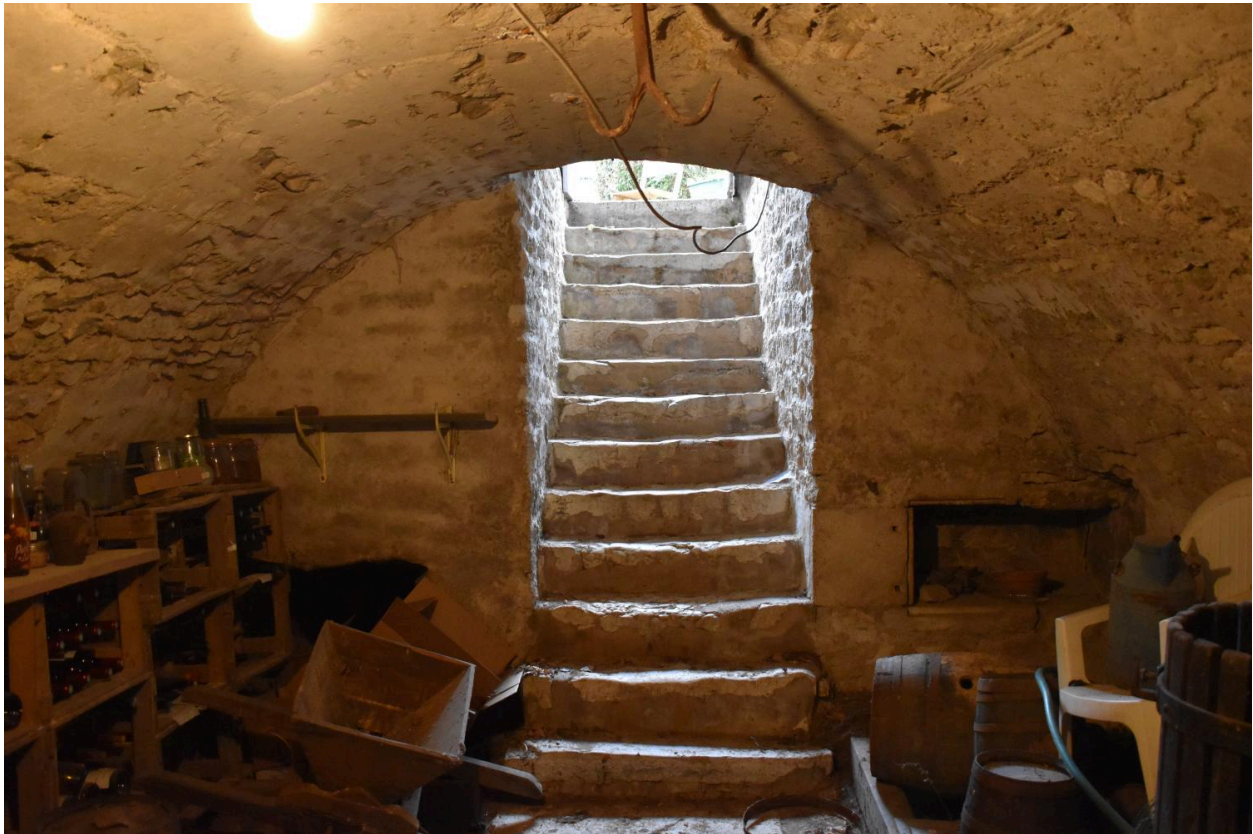
Détail de l'escalier d'accès à la cave.
