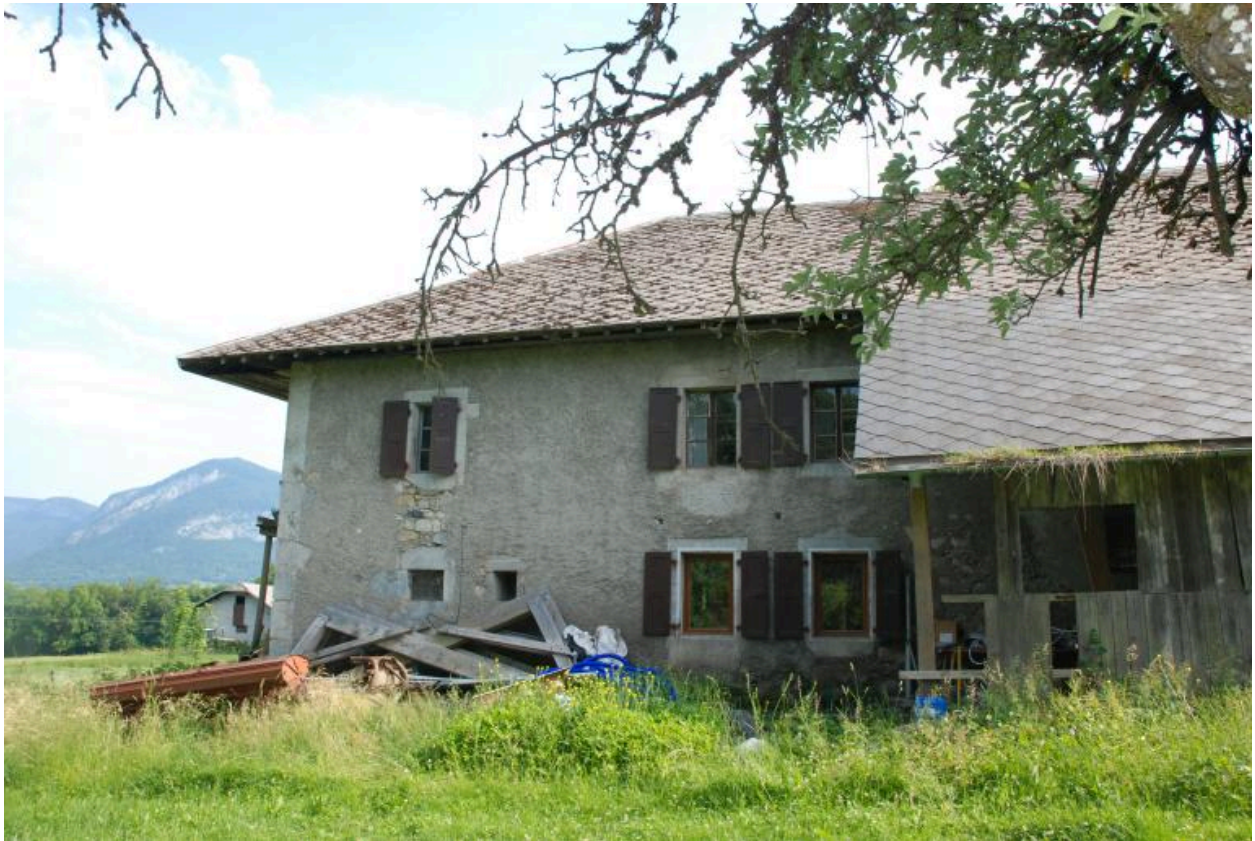
Vue arrière du bâtiment principal, partie habitation.
