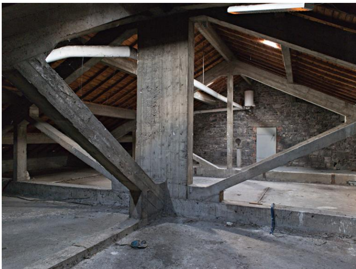
Hôtel-Dieu de Clermont-Ferrand. L'hôtel-Dieu, corps de bâtiment sud, extrémité sud-est, charpente en béton armé du toit.
