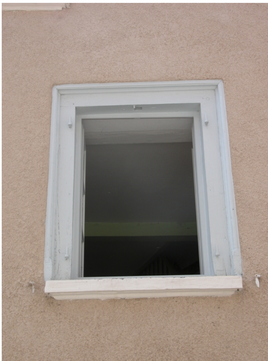
Îlot 10. 8 Mai 1945 (rue du) 03. Détail de baie de la façade sur rue.
