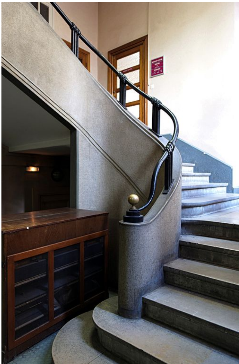
Vestibule : détail de l'escalier
