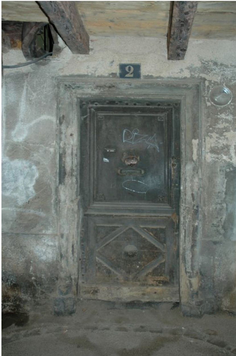
Porte piétonne sous le passage couvert.
