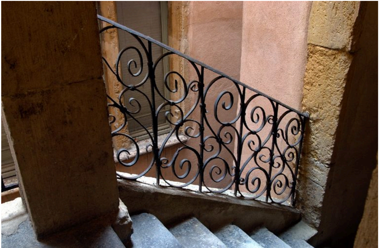
Garde-corps de l'escalier
