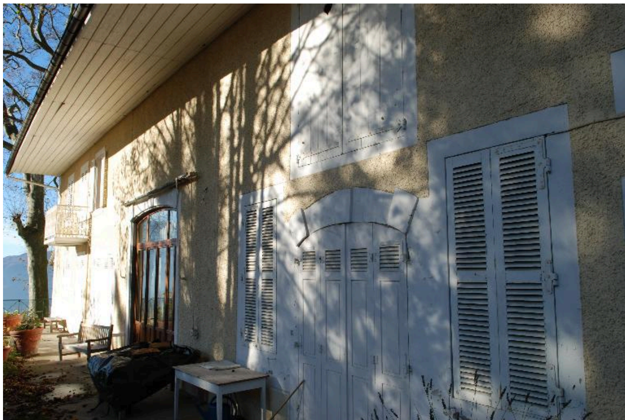
Sous les Côtes, maison bourgeoise la Maison Blanche, 2014 C2 251, 259. Vue partielle de la façade principale.
