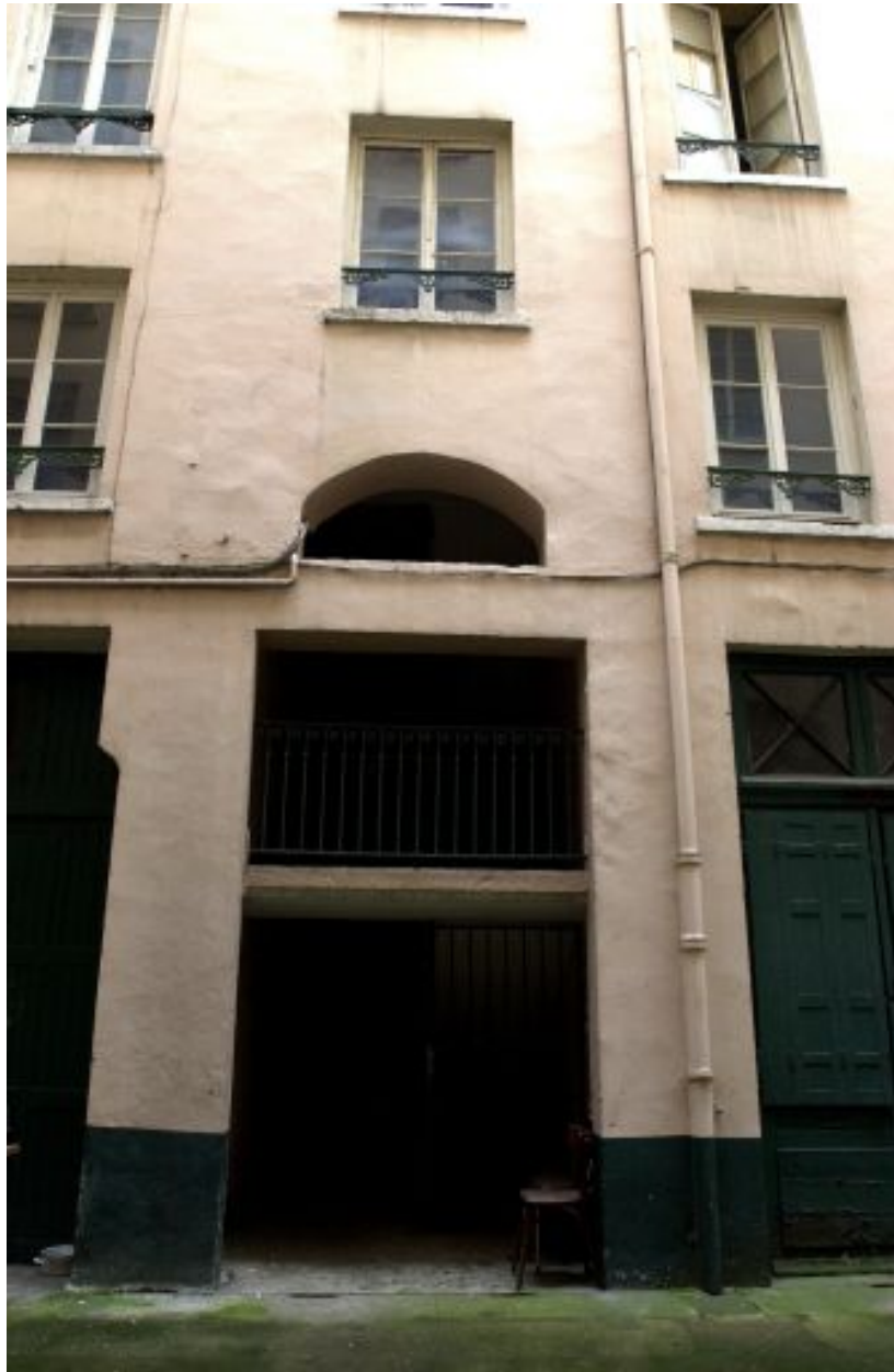
Vue de la travée d'escalier du corps de bâtiment en fond de cour
