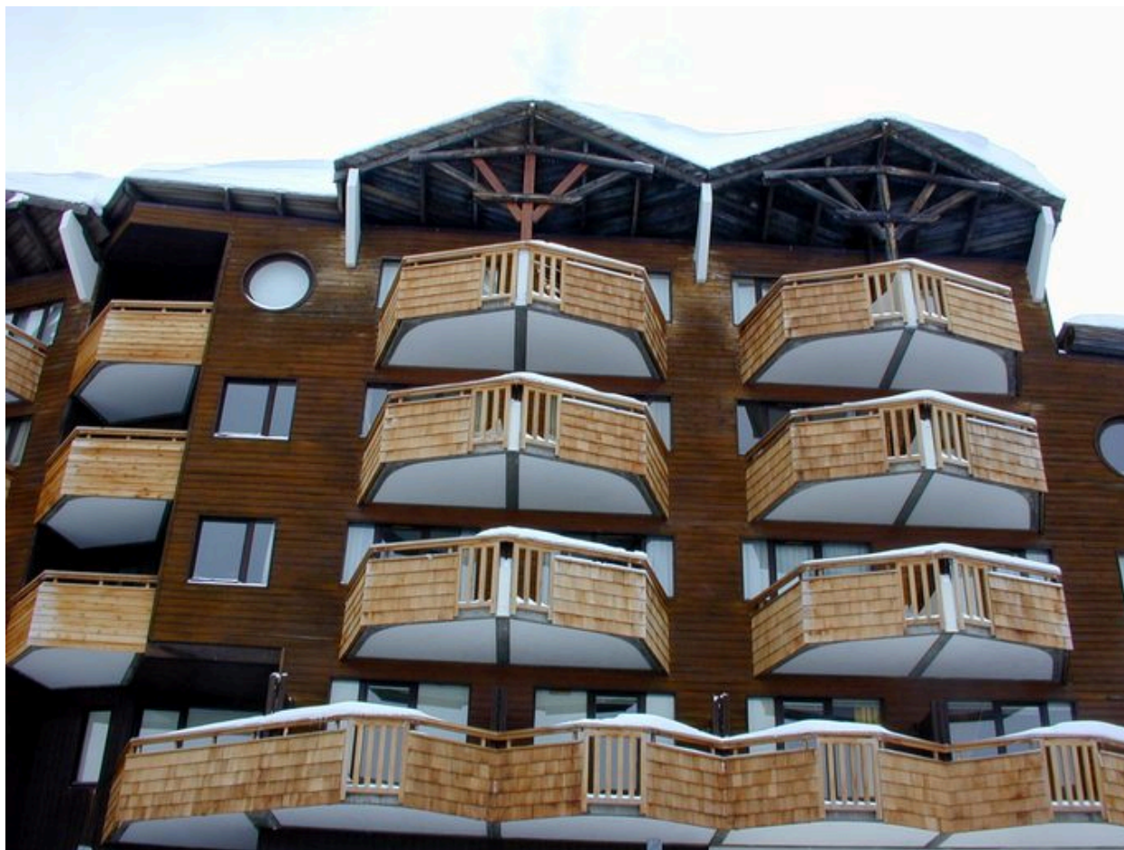
Détail des balcons de la façade aval
