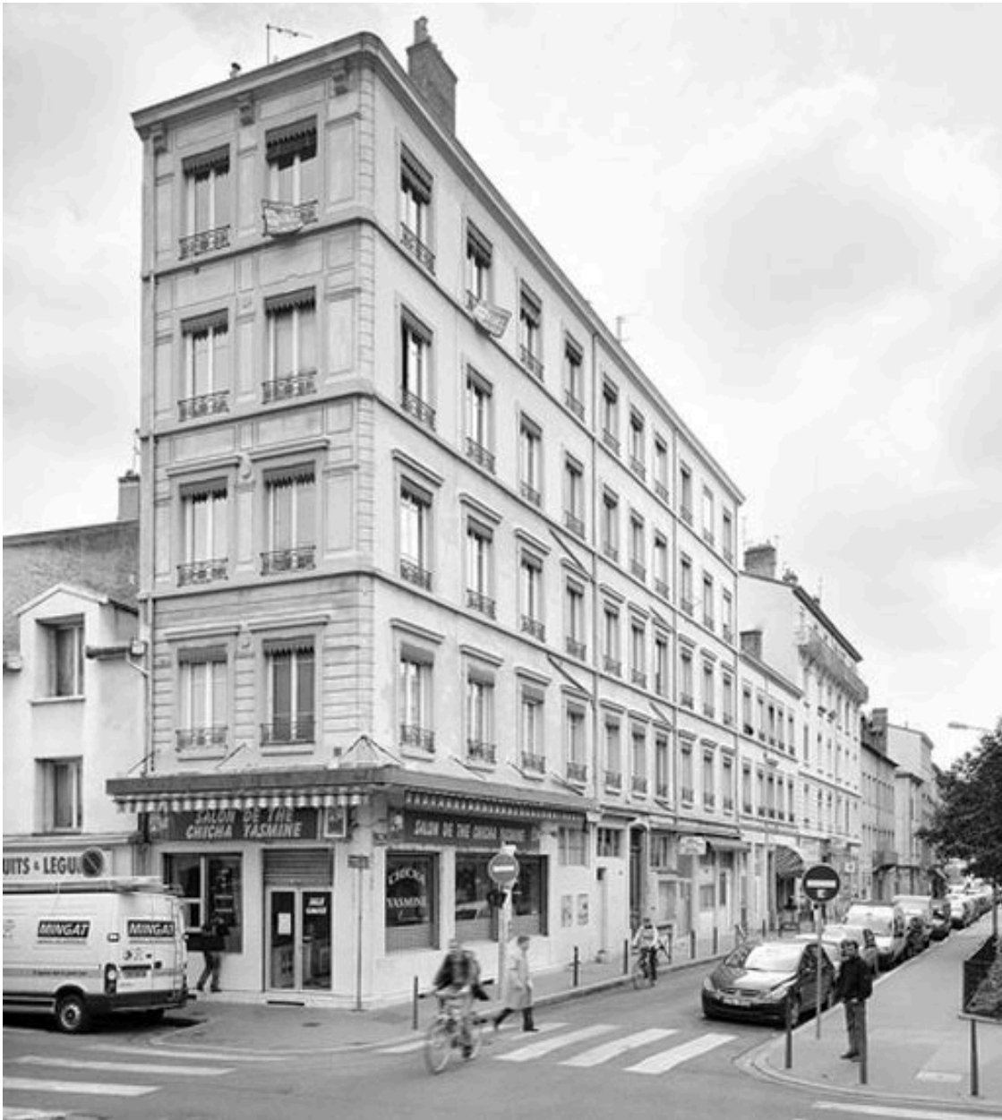
Vue générale depuis le nord
