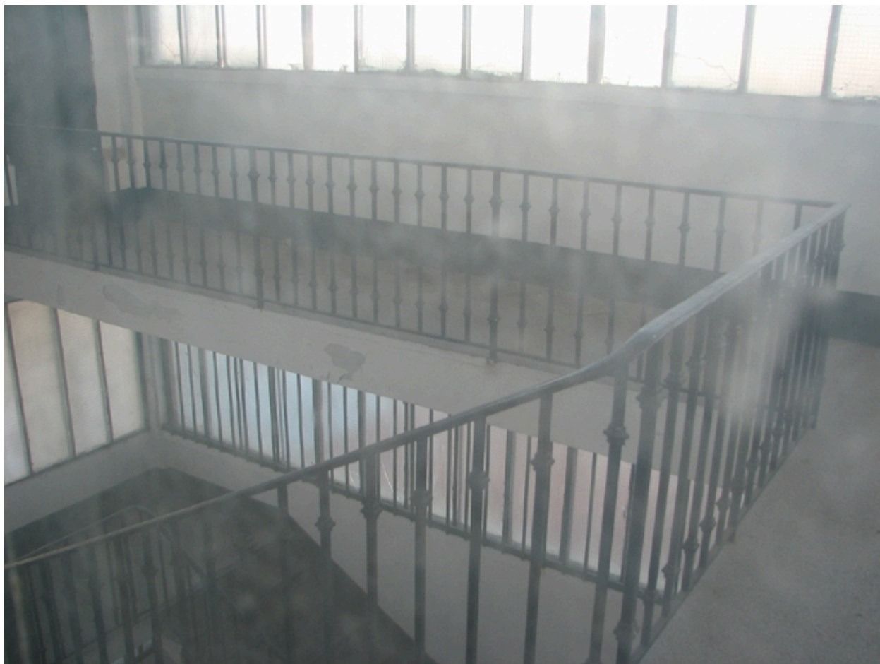
Vue des escaliers
