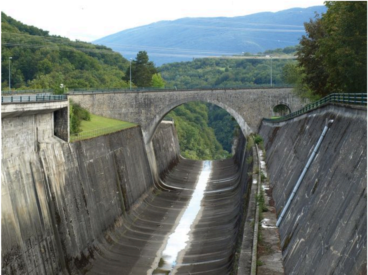
Vue générale, face amont, de la rive droite
