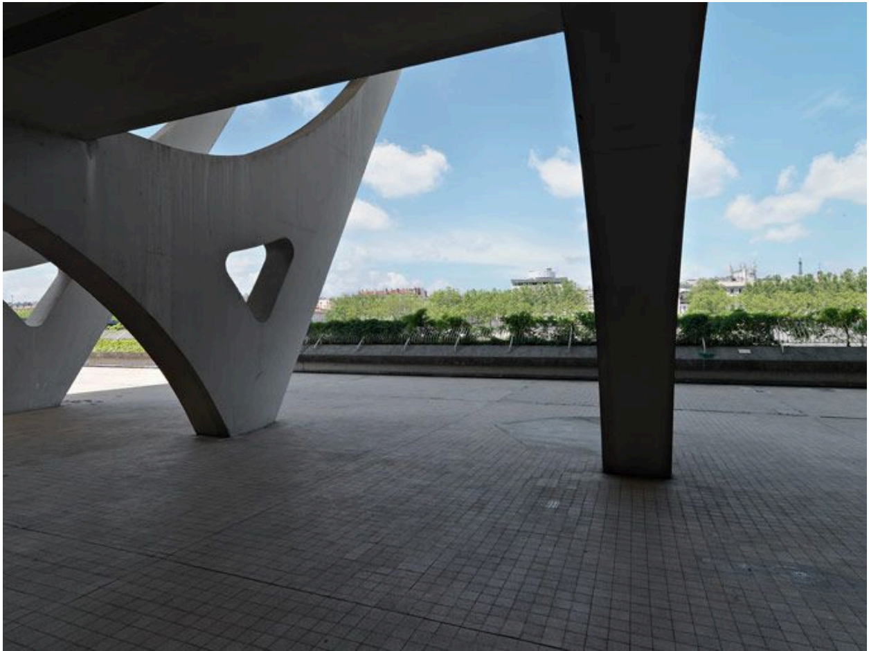
Détail du soubassement du bâtiment d'exploitation (état juin 2012).
