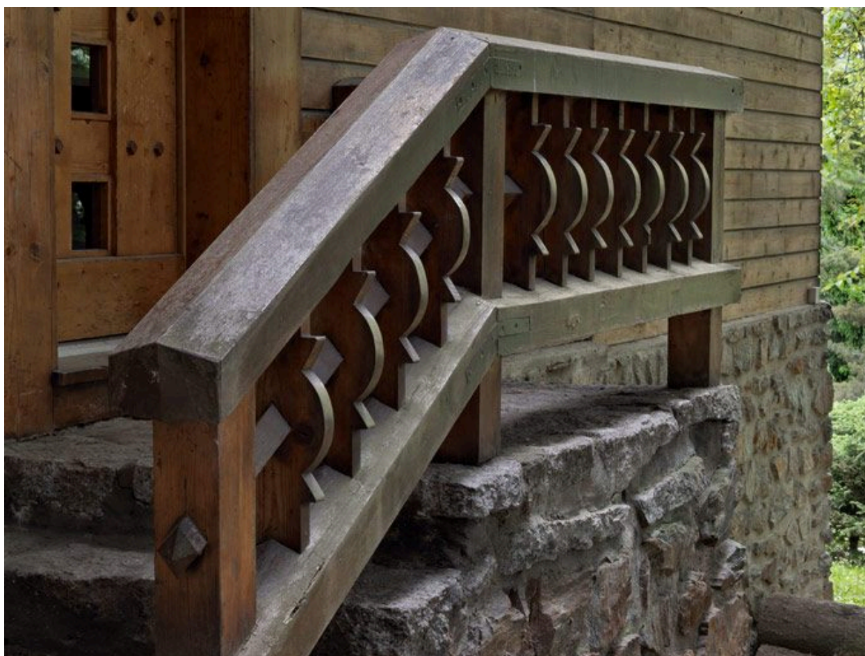
Garde-corps de l'escalier d'entrée
