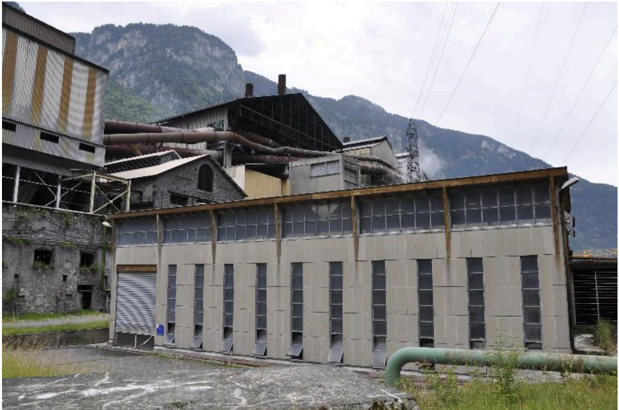
Vue de la façade principale de Pierre-Eybesse III
