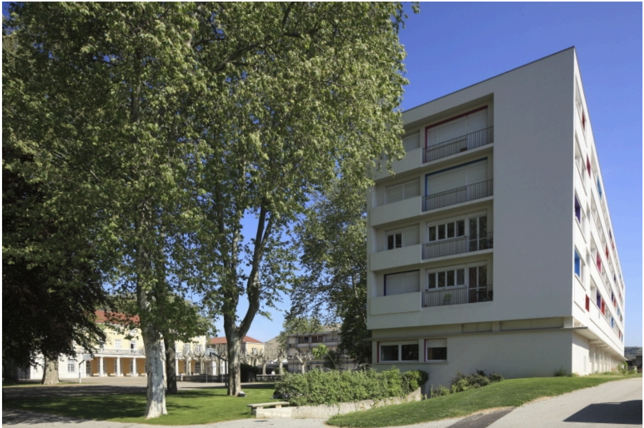
Bâtiment E de l'internat, 1963.
