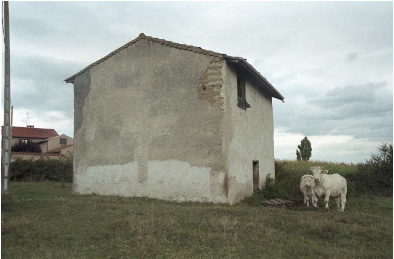
Boën, le Domaine Bailly, grange étable (1986 AD 101). Vue d'ensemble.
