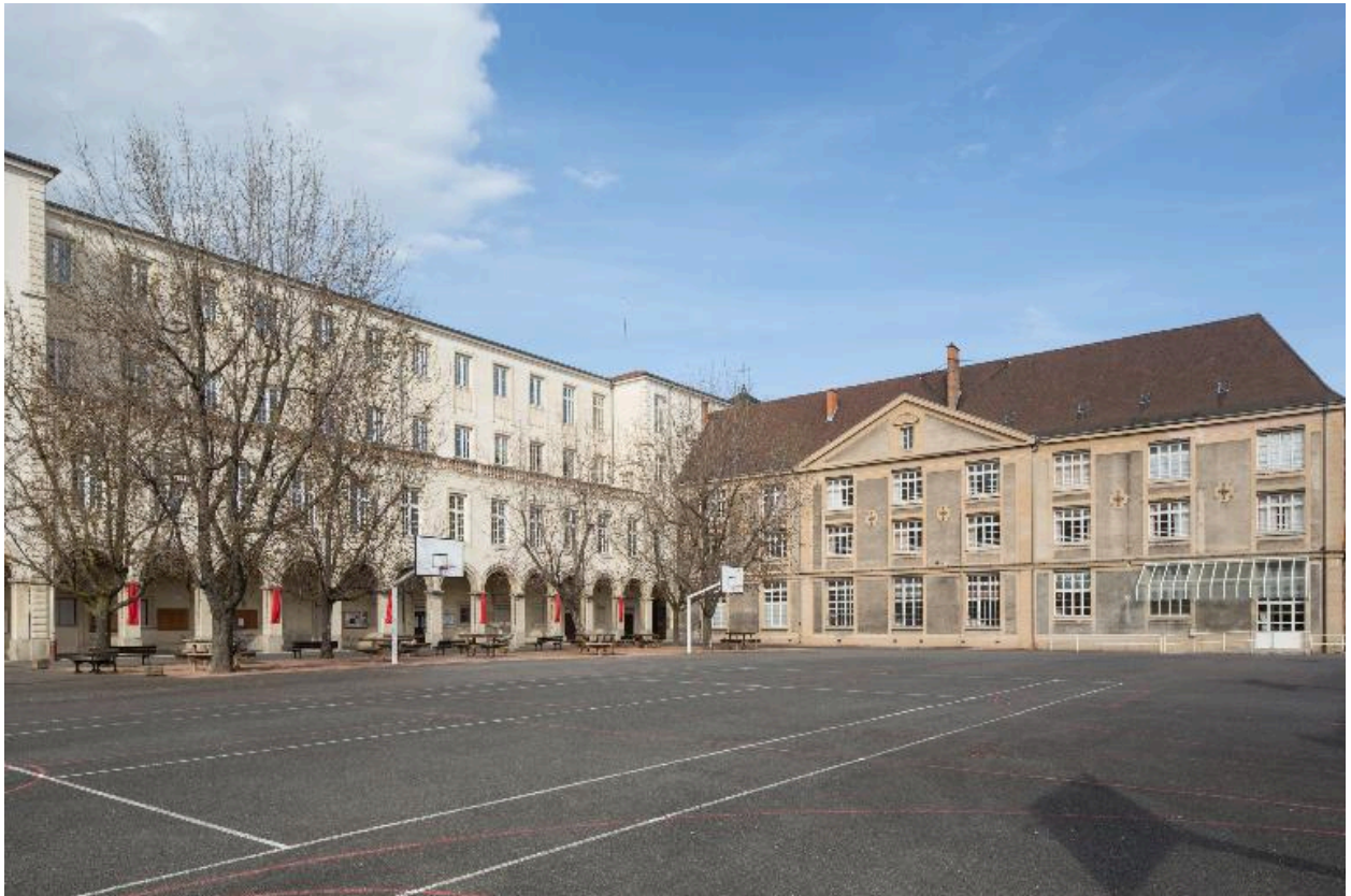
Bâtiment G et bâtiment H : angle de la cour
