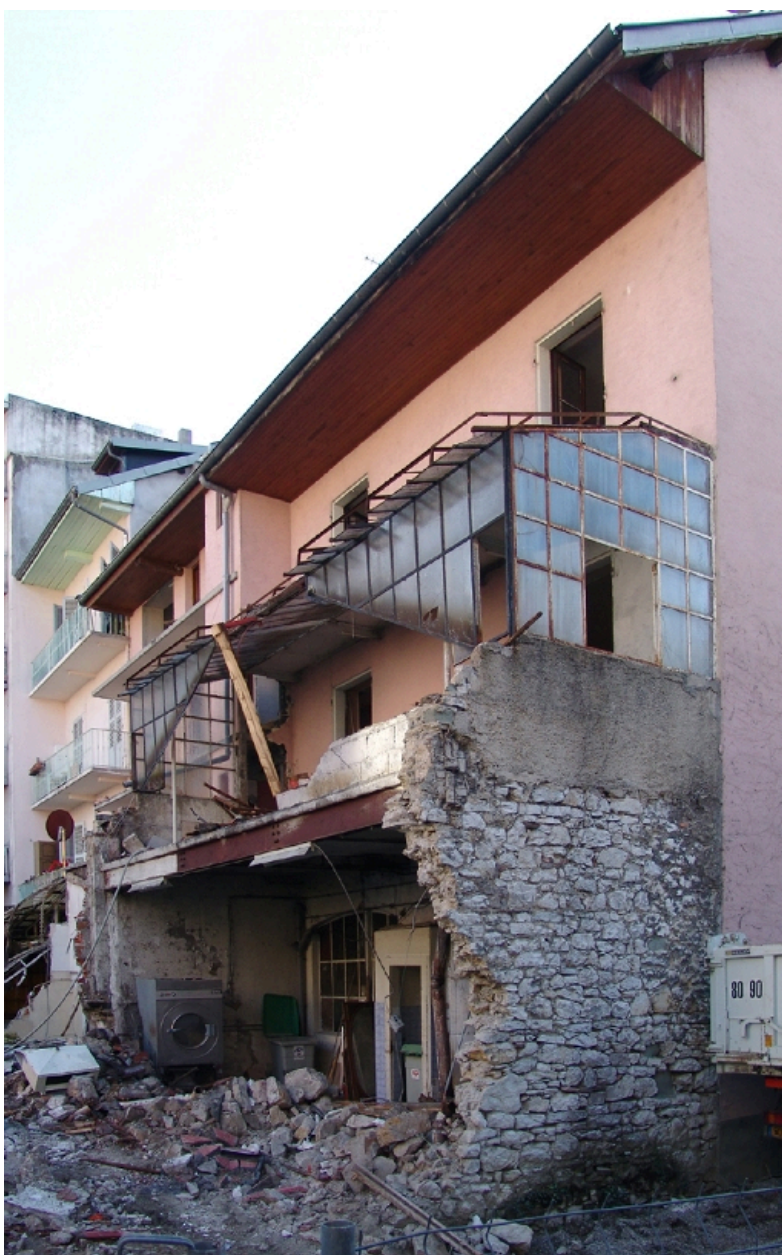
Démolition de la véranda
