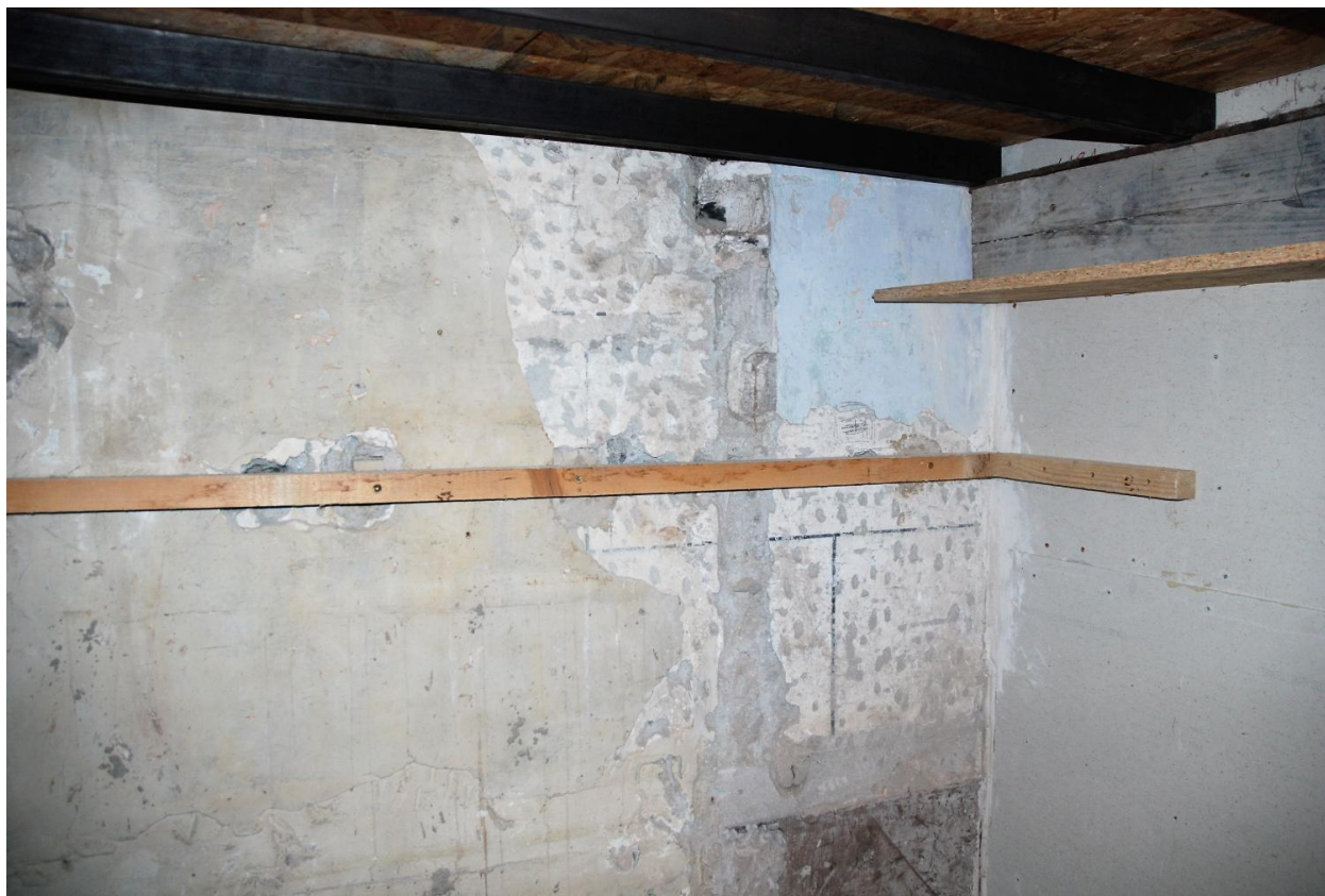
Maison, immeuble, 100 rue Louis Blanc-Pinget (2018 E1 1797). Vue intérieure du rez-de-chaussée. Décor de faux appareil sur le mur de fond des boutiques voûtées.
