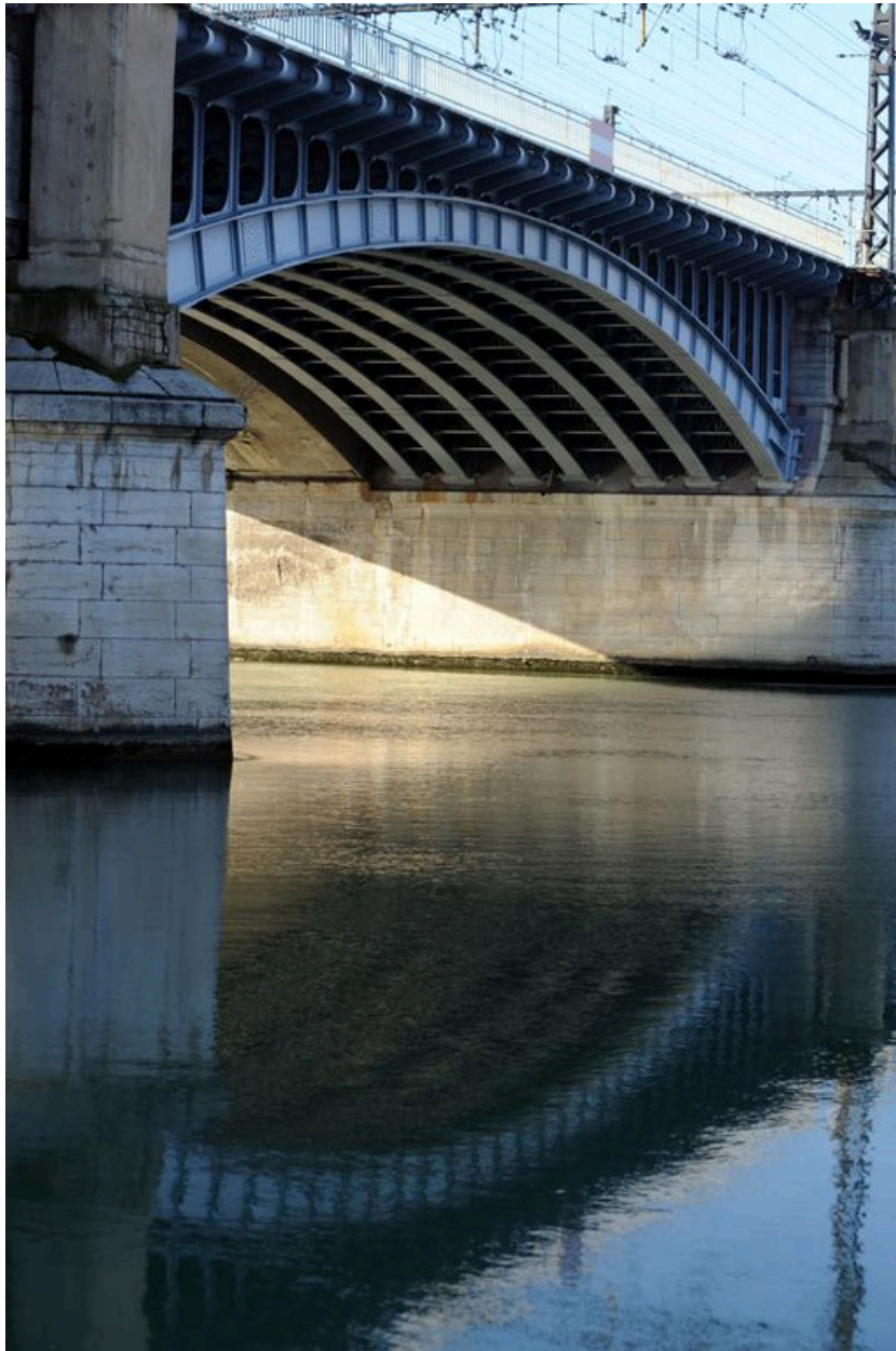
Arche, de côté, face amont, vue générale (depuis la rive gauche)
