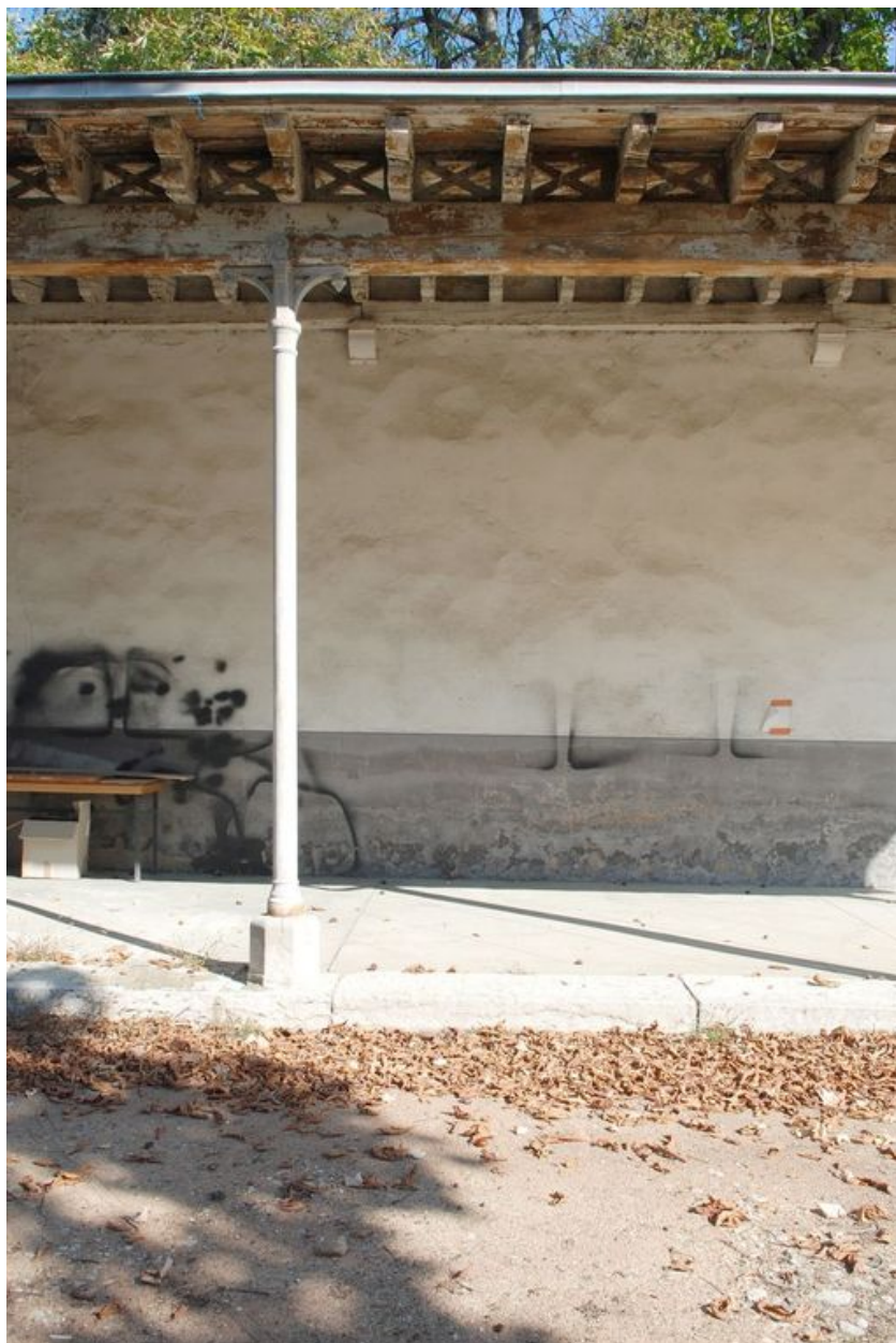
Détail du portique qui reliait le bâtiment 504 à un édicule : colonnette en fonte, charpente et éléments décoratifs en bois
