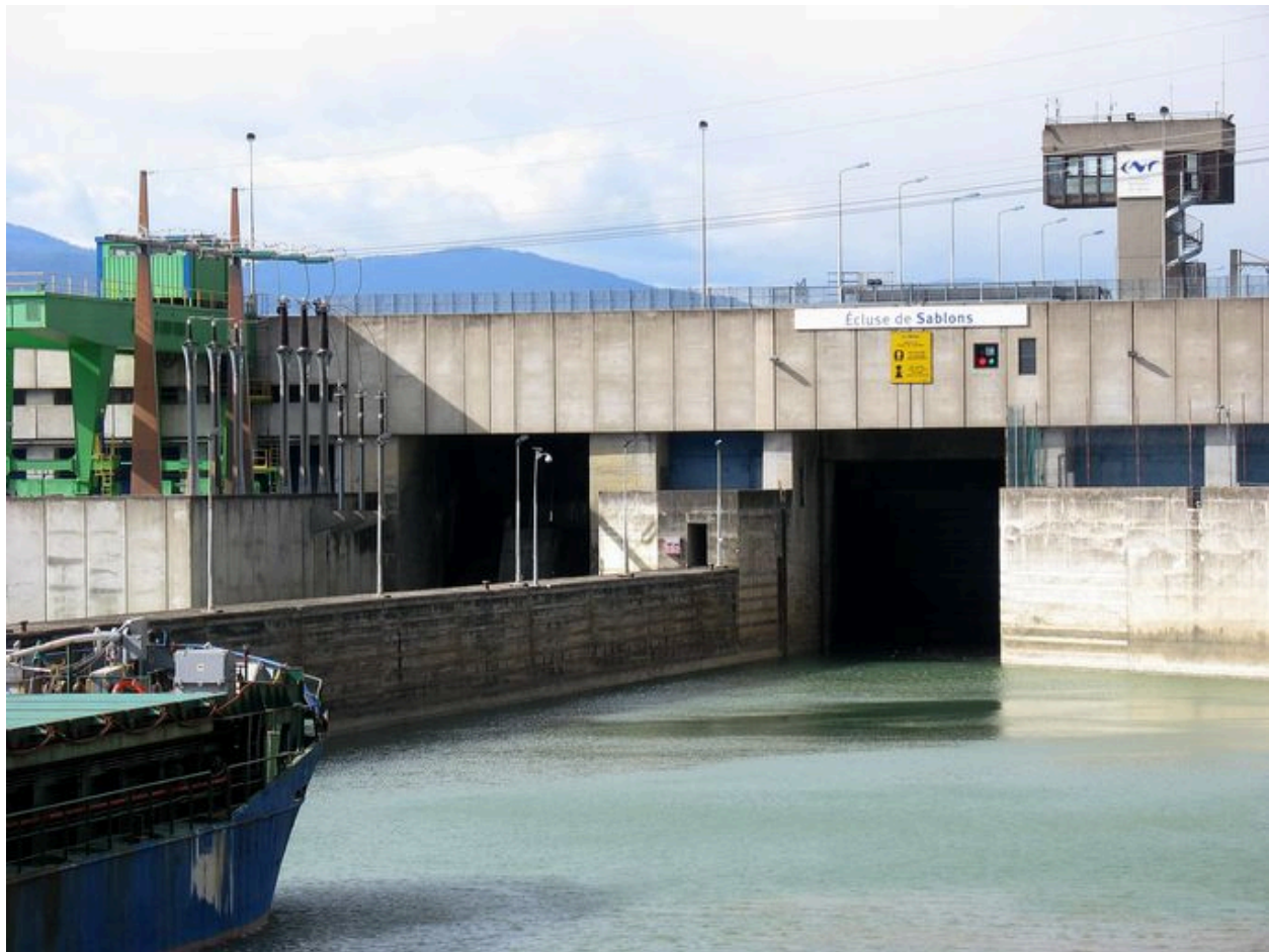
Vue partielle, écluse, côté aval
