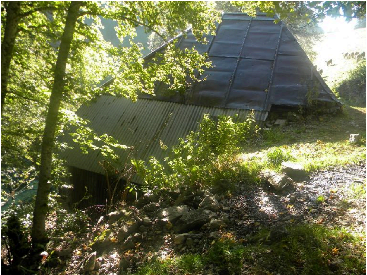
Vue de trois-quarts nord-ouest du bâtiment semi-enterré.
