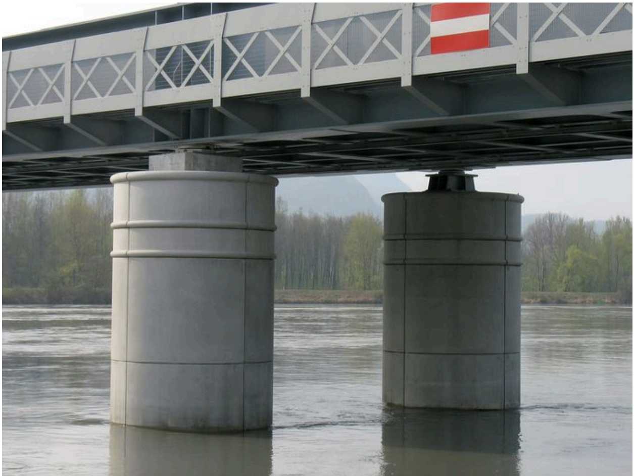
Vue partielle : paire de piles
