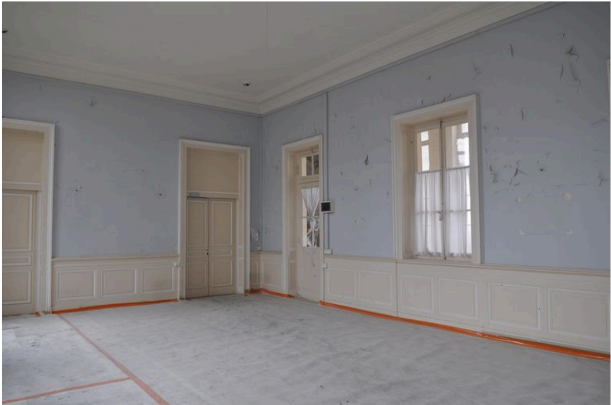
Vue de l'ancien parloir-salon en 2010, durant les travaux de transformation.
