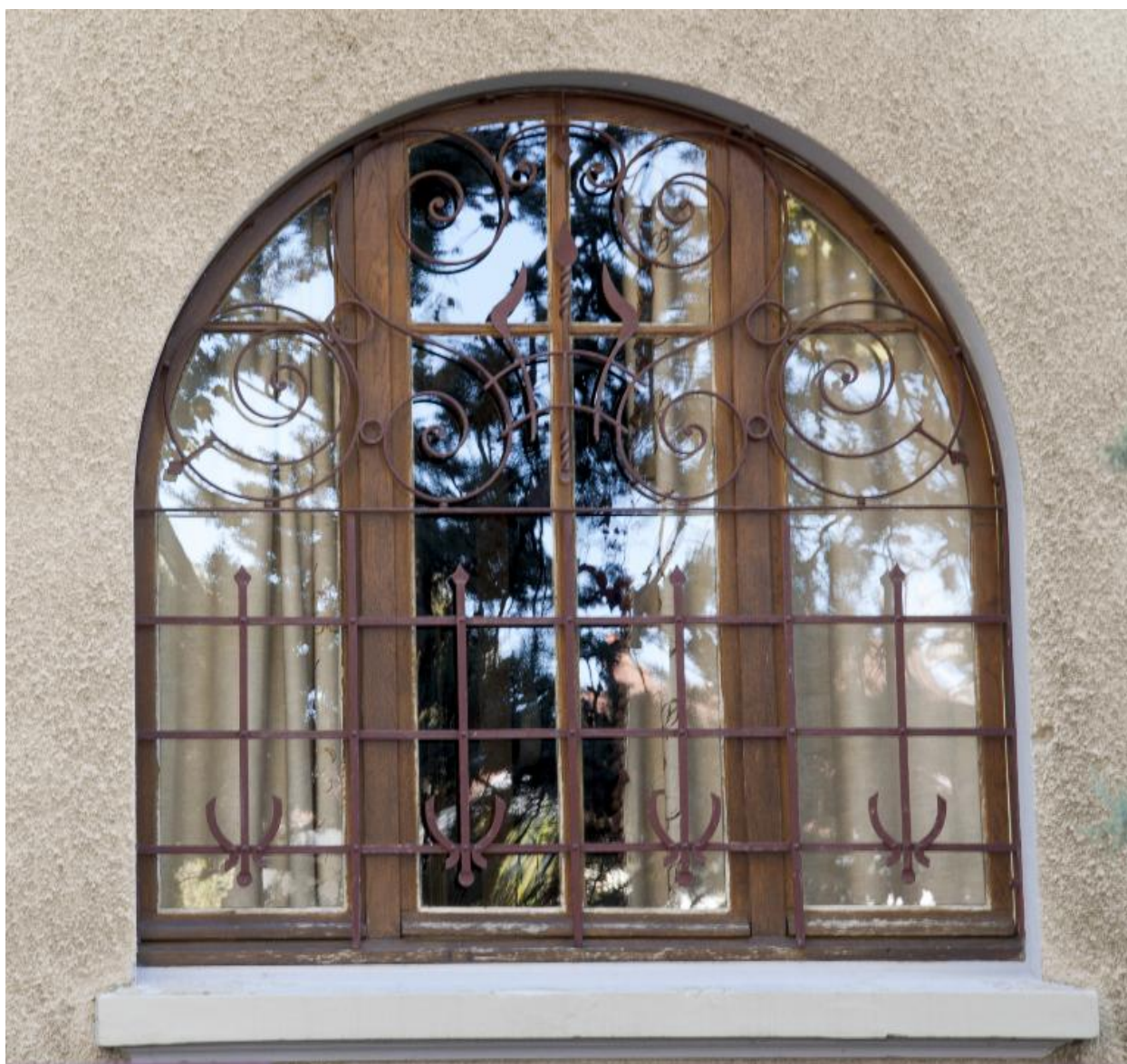
Baie en plein cintre sur la façade principale
