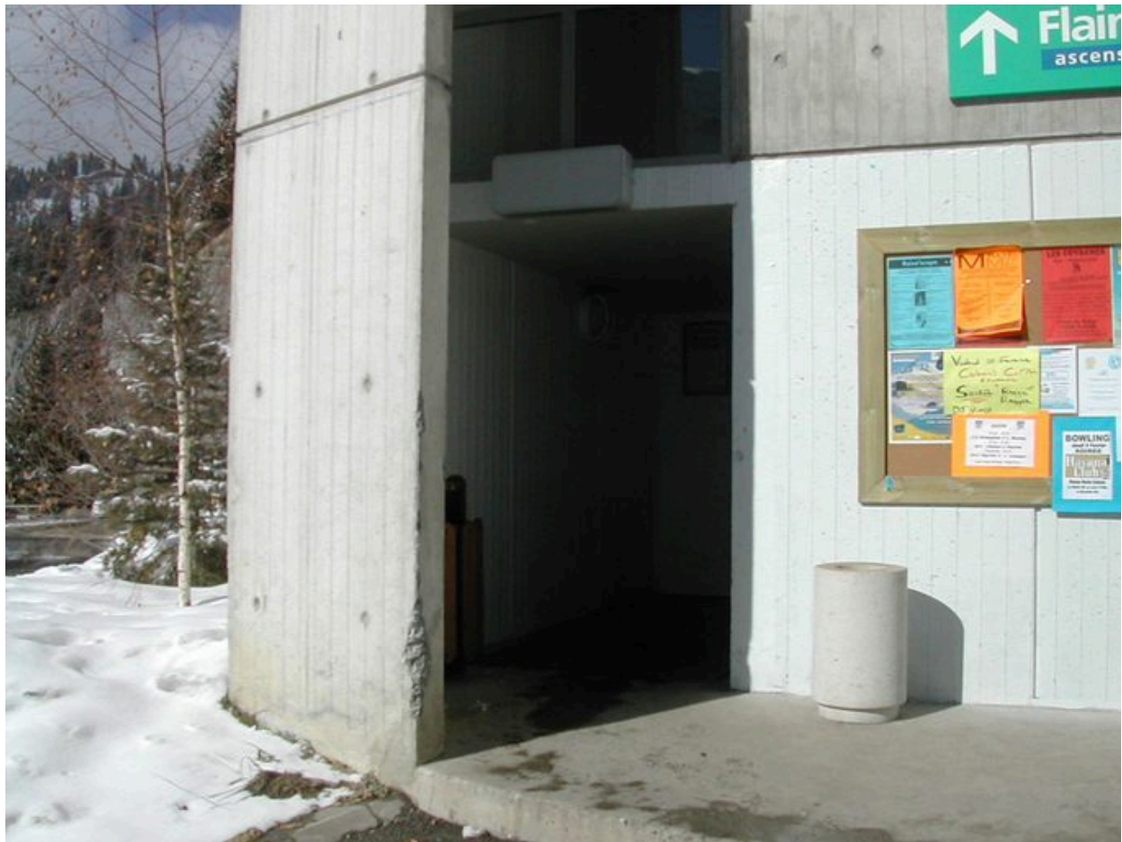
La gare inférieure. L'entrée vers la cabine d'ascenseur
