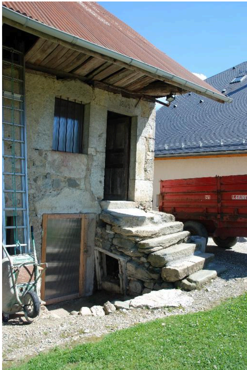
Habitation (2014 A1 1405, partie nord), non repérée : détail de la porte avec escalier extérieur.
