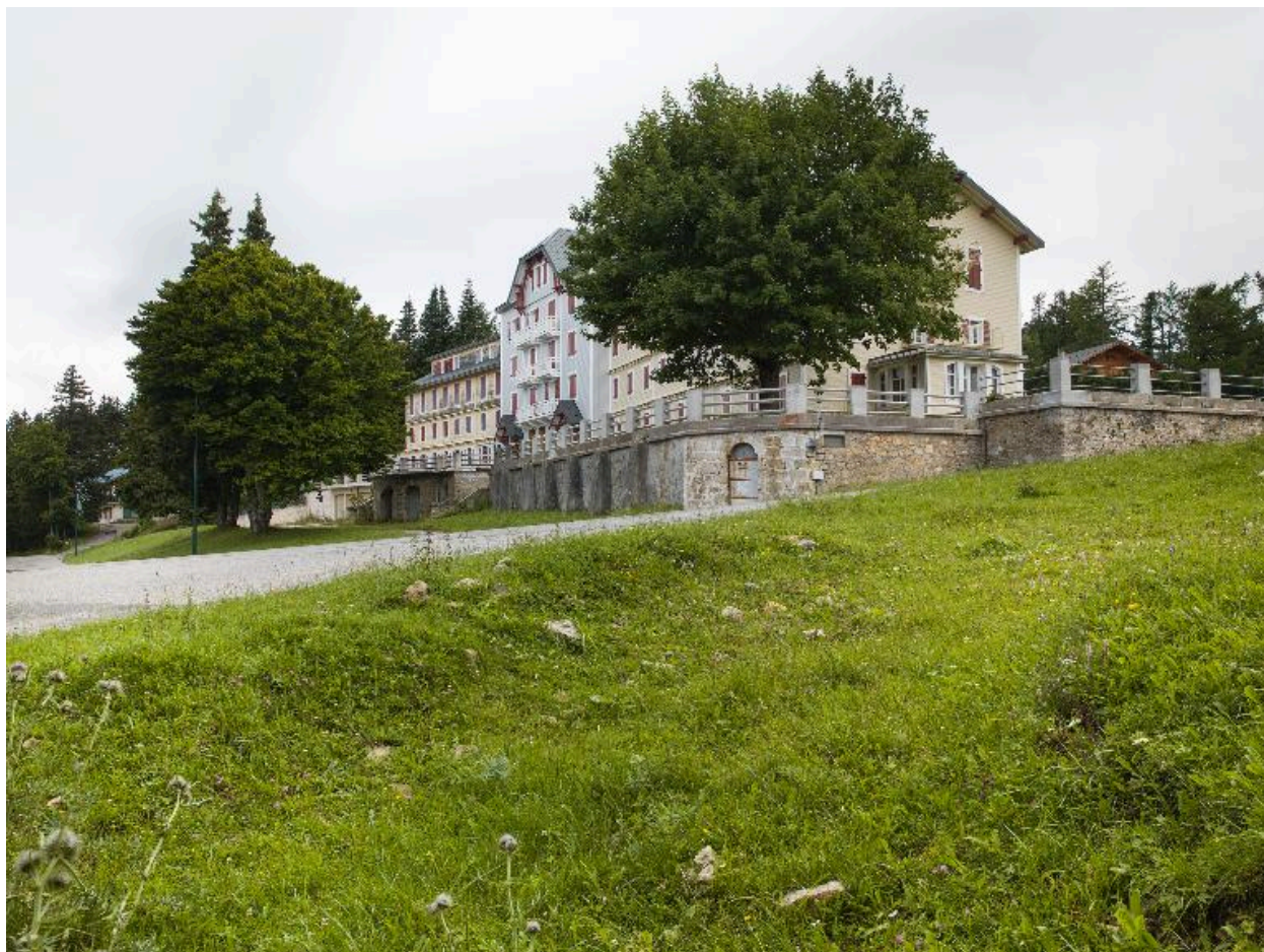
Vue d'ensemble : façade principale et pignon nord
