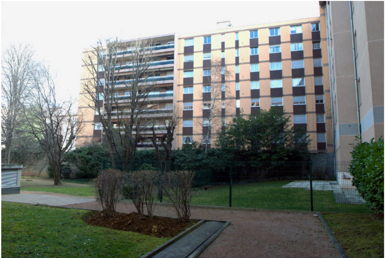
Elévation postérieure ouest
