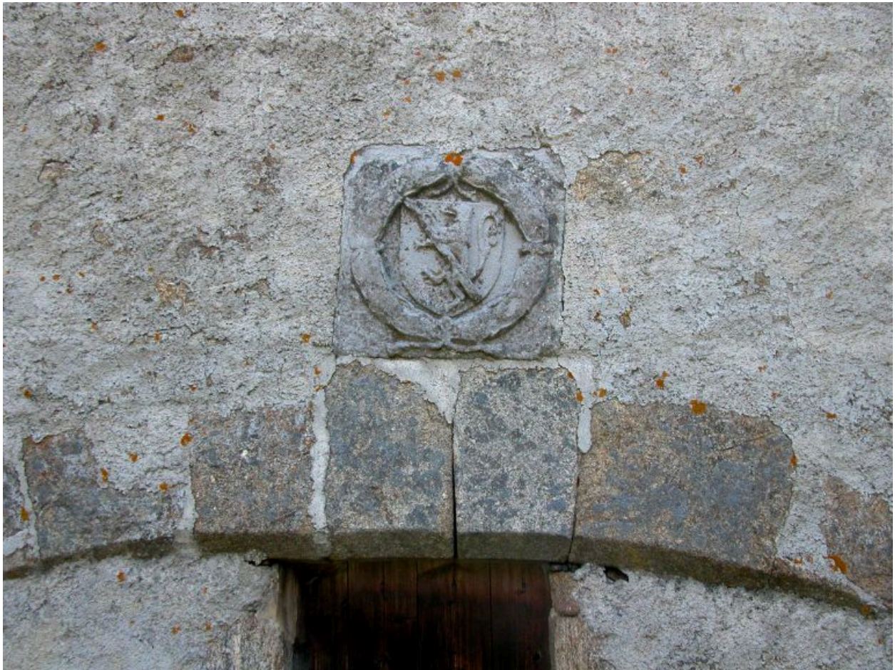
Premiers communs, détail armoiries rapportées au-dessus du portail arrière de la grange.
