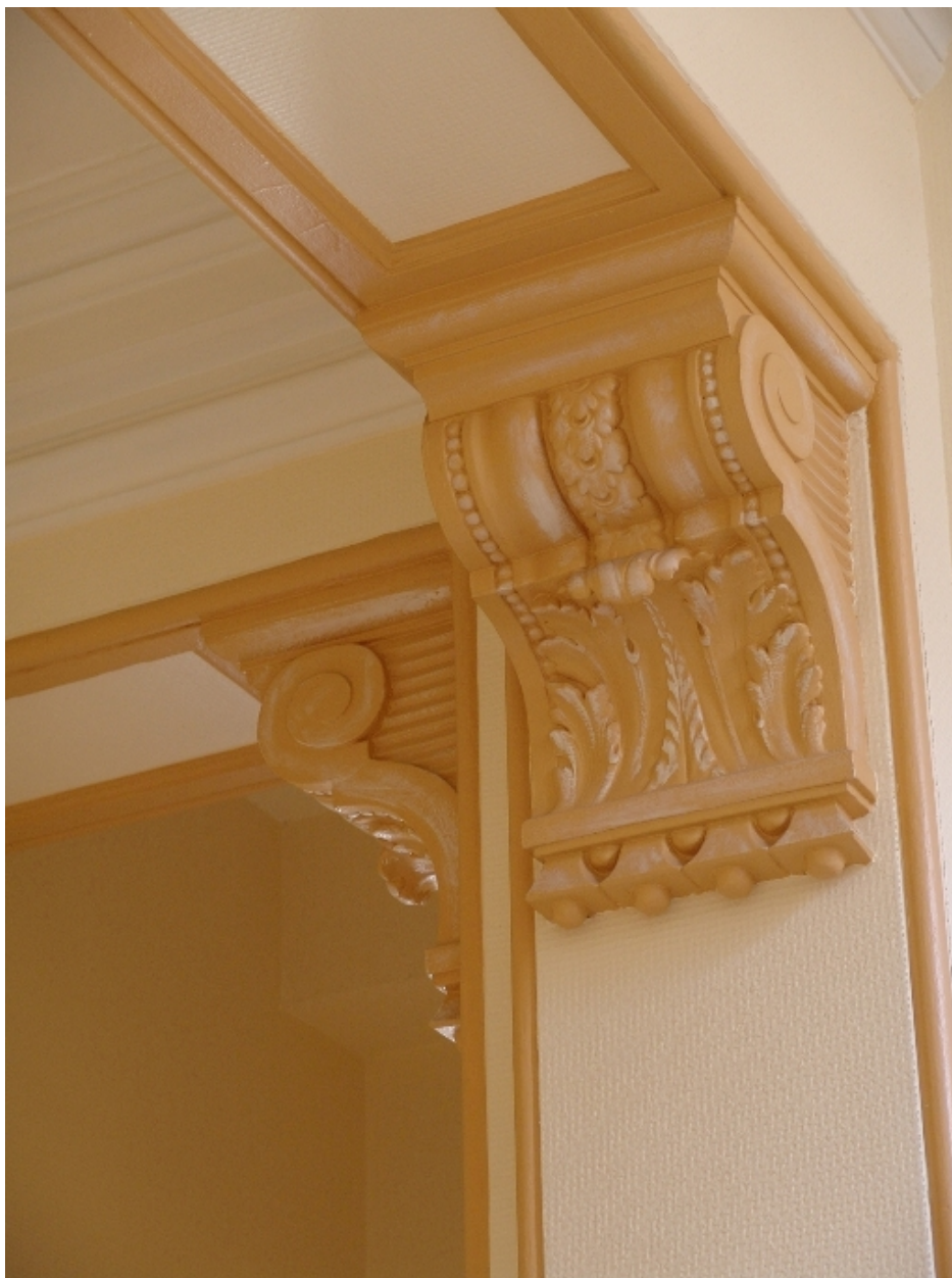
Consoles dans le vestibule
