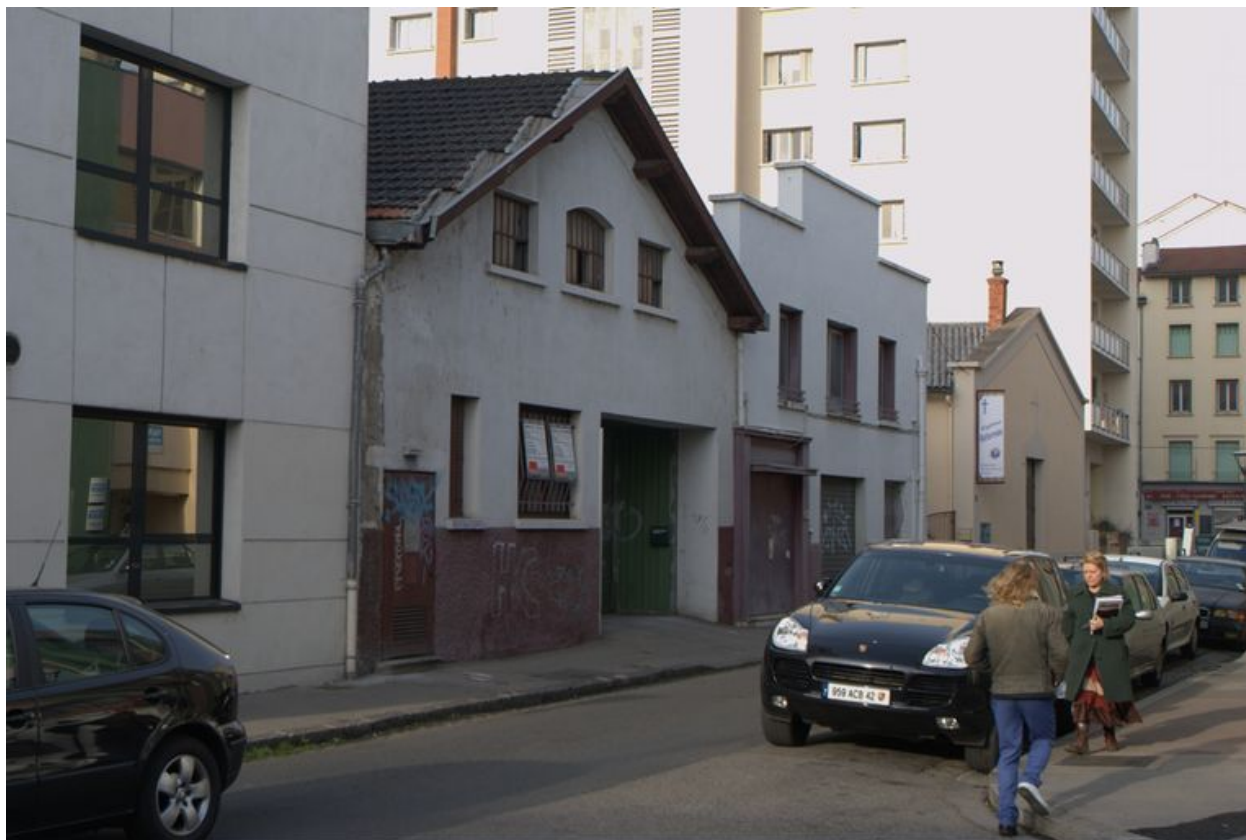
Vue d'ensemble rapprochée depuis le sud
