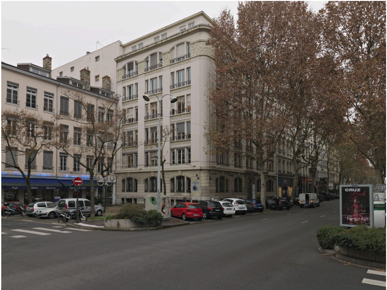
Vue de la façade principale place Kléber
