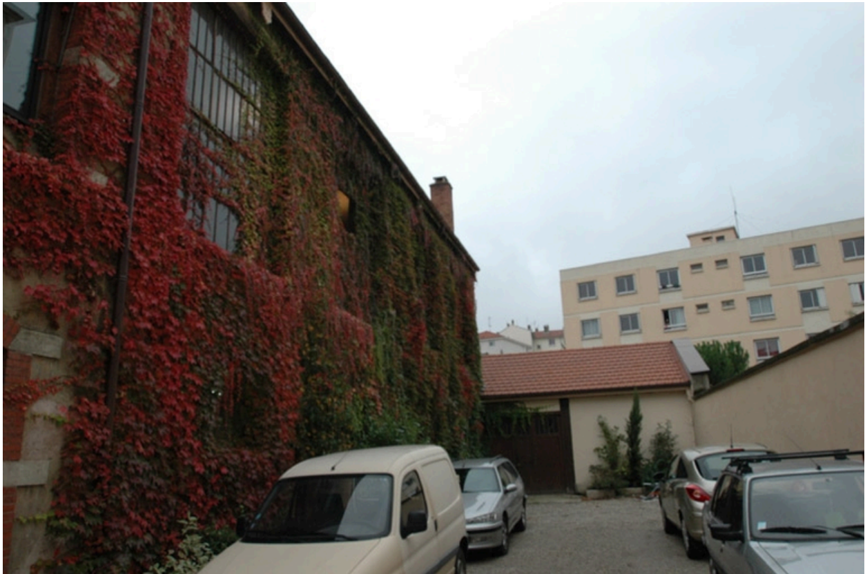
Baies atelier à bras (1er étages), vue nord-ouest
