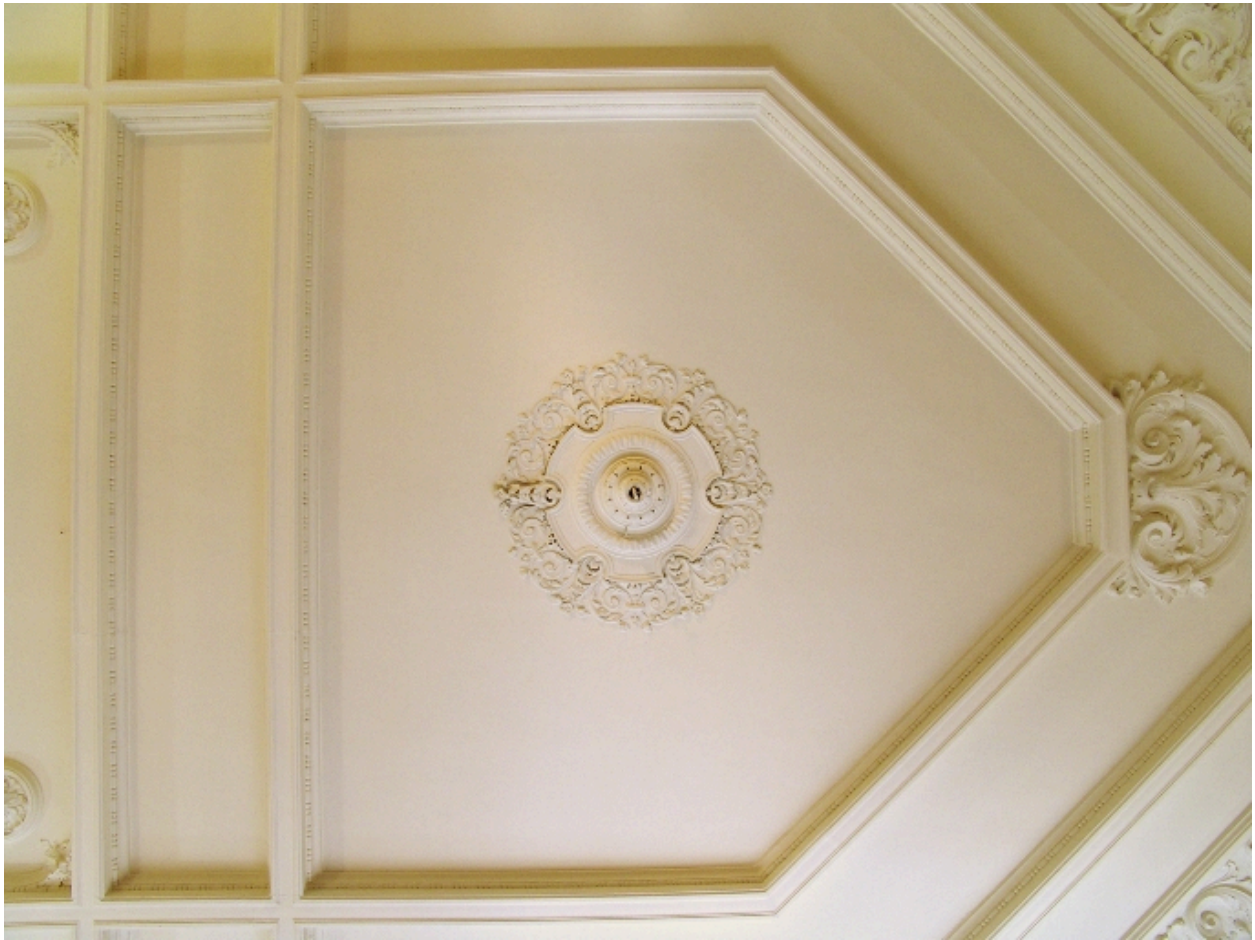
Plafond à décor de stuc, rez-de-chaussée
